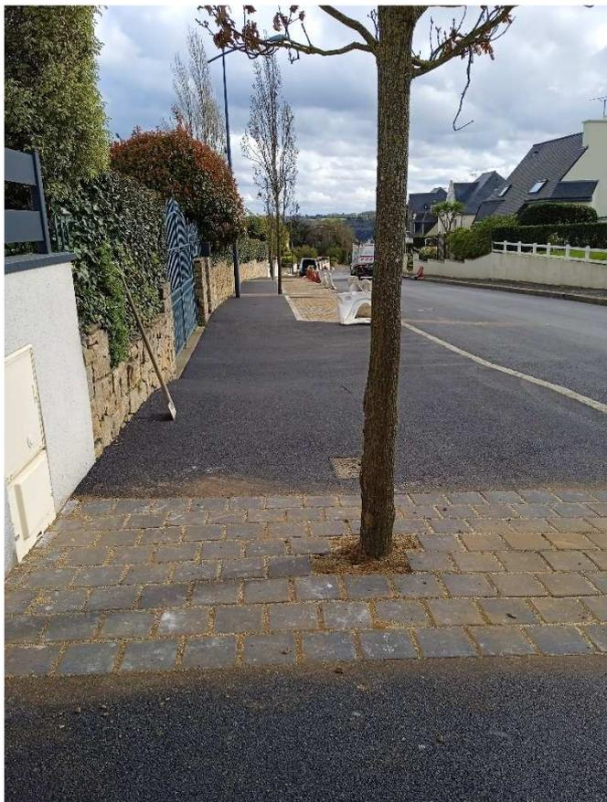
Pavés béton autobloquant – PMR - joints engazonnés de 15mm.
