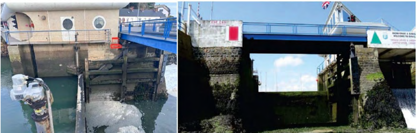
Figure 4: Etat actuel de la porte écluse du bassin à flot
