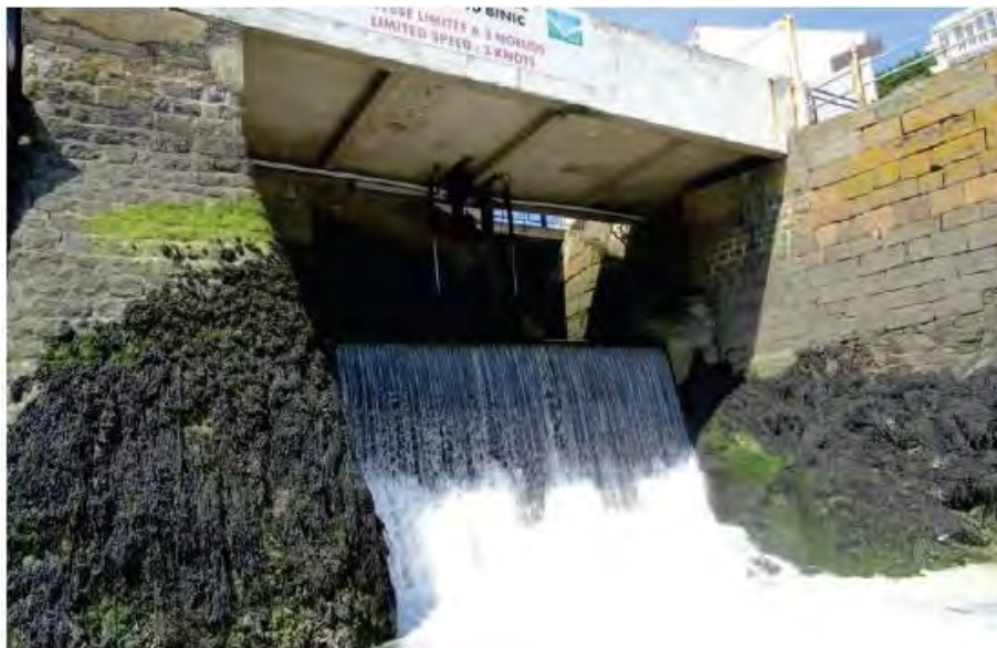
Figure 6: Barrage déversoir du port de Binic
