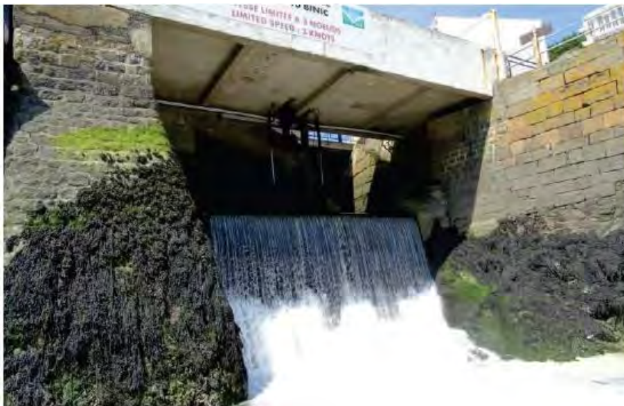
Figure 6: Barrage déversoir du port de Binic
