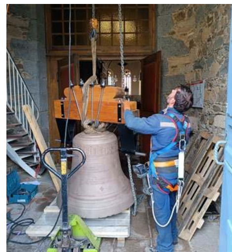
Remontage de la cloche de l'église Notre-Dame d'Étables-sur-Mer
